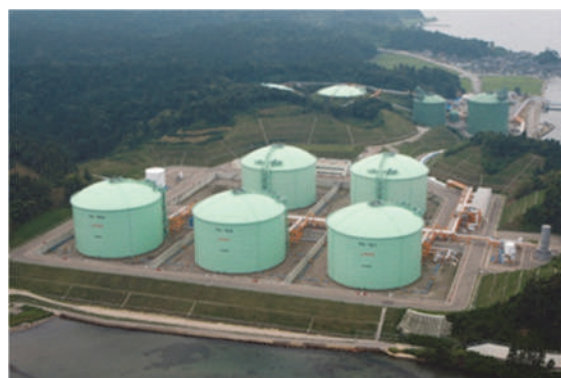
七尾国家石油ガス備蓄基地
